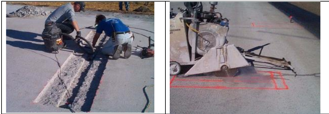
شکل ۹- طریقه نصب صفحه خمشی [۹]
