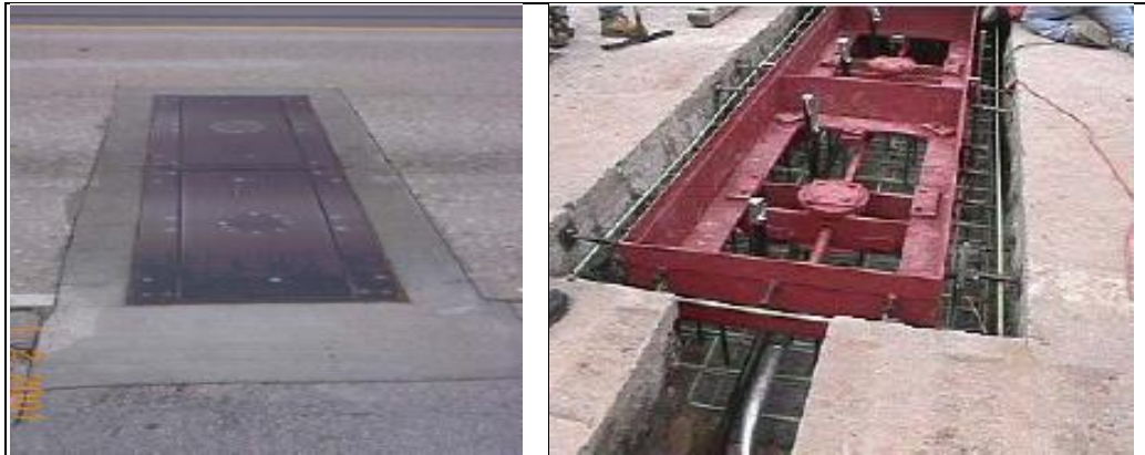
شکل ۱۱- طریقه نصب سیستم لودسل [۹]
