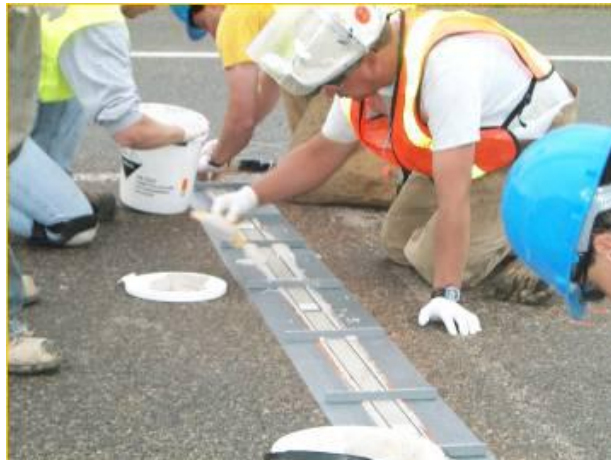
شکل ۷- طریقه نصب سنسور کوارتز [۱۶]
